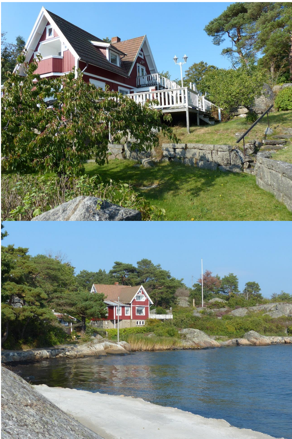
Figur 17. Byggnaden D1 sommarvillan Gläntan.
