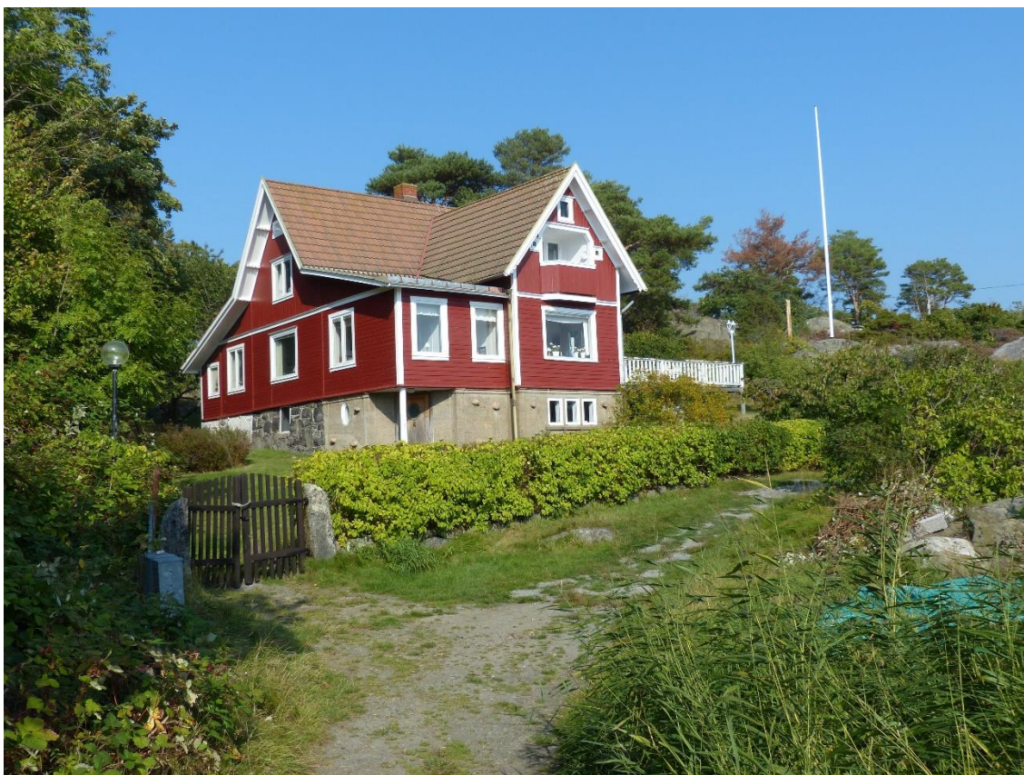
Figur 16. Byggnaden D1 sommarvillan Gläntan.
