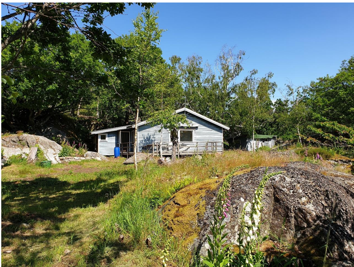
Figur 11. Byggnaden A3 fritidshus i skogsbrynet.
