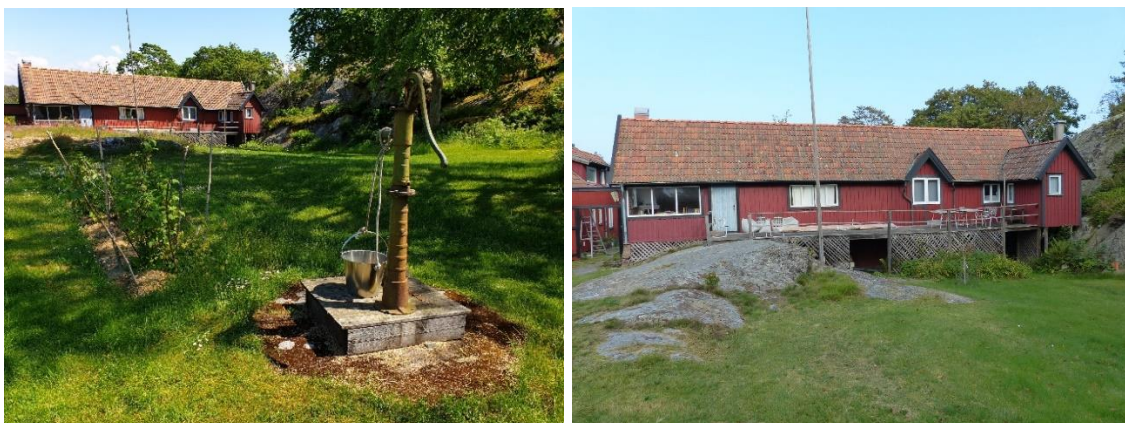
Figur 10. Byggnaden A2 före detta ladan.
