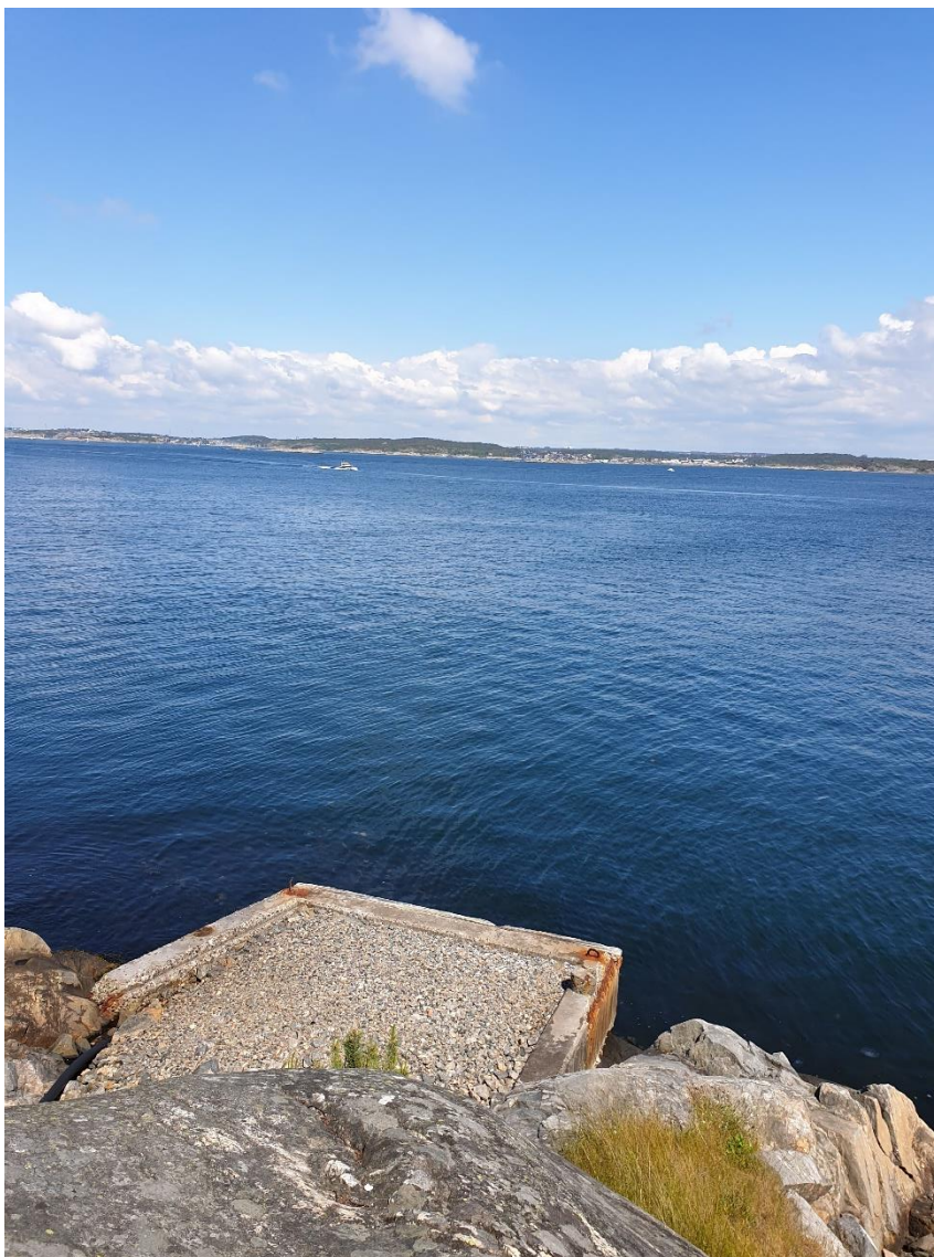
Figur 14. Kaj nedanför byggnaden B2.
